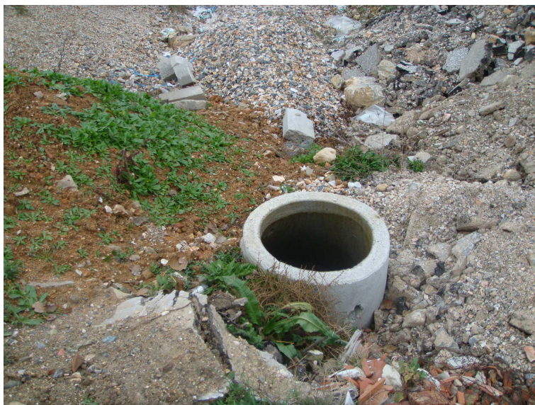
Φώτο 12: Φρεάτιο ελέγχου τσιμεντοσωλήνα Φ1000.
