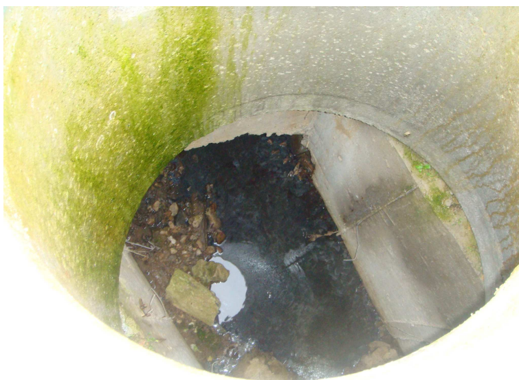
Φώτο 12: Φρεάτιο ελέγχου τσιμεντοσωλήνα Φ1000.
