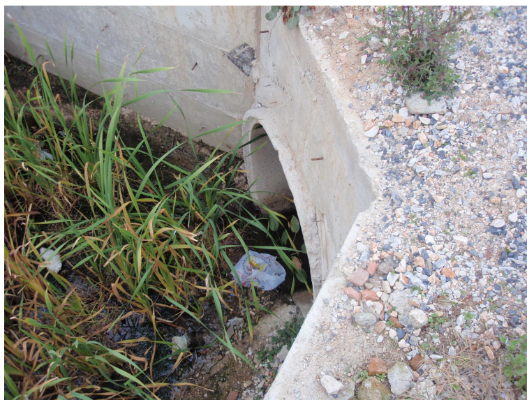
Φώτο 5: Τεχνικό εισόδου Ρέματος 2 και εισροή στον Τ/Σ Φ1000.
